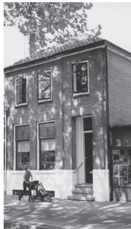
▲ Ook panden die niet als monument staan geregistreerd kunnen voorzien worden van blinden: Graaf Ottosingel 127 voor montage (foto J.S. Krijnen – gemeente Zutphen)
