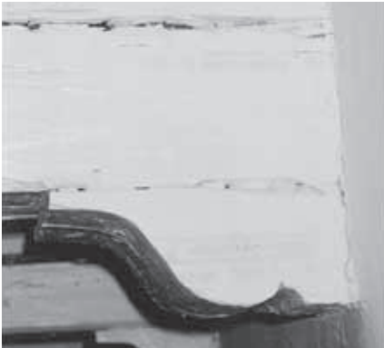
▲ Balk met console op de huidige eerste verdieping. (Afb.15) (foto J.S. Krijnen - gemeente Zutphen)
