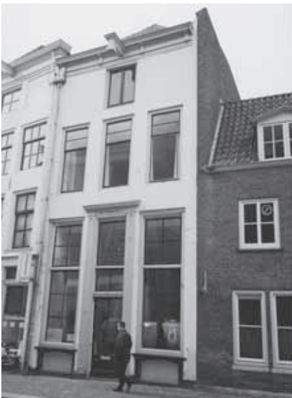
▲ Lange Hofstraat 31 heeft nog een "Diele" aan de straat. Let op de hoge vensters in vergelijking tot de buurtpanden. (Afb.18) (foto gemeente Zutphen)
